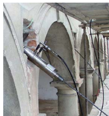
Oprava kleneb barokní kolonády.
